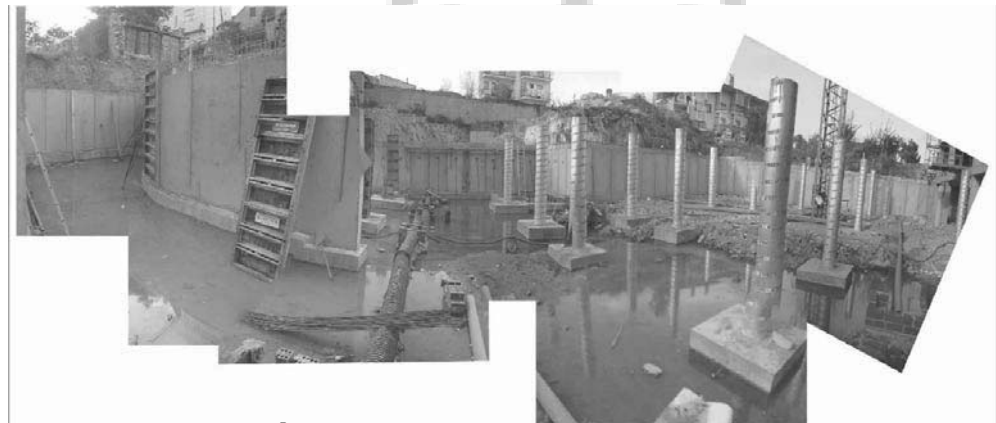
PATOLOGÍA PRESENCIA DE HUMEDAD
